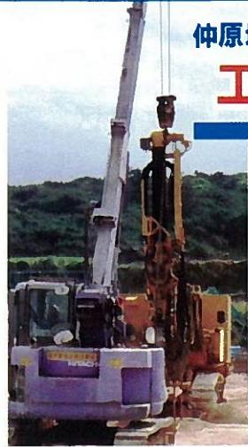
仲原地下ダムの工事が平成二十三年より止水壁築造工事に入り本格化しています。地下水が海に流れるのを防ぐ止水壁築造工事は、SMWとよばれる大型機械スクリューで掘削した土とセメントミルクを注入しつくられます。
