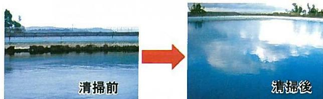
各ファームポンドの底盤には泥が蓄積されるため、末端フィルター詰まり等の管内トラブルを防止する為に2年に1度清掃を行っております。
