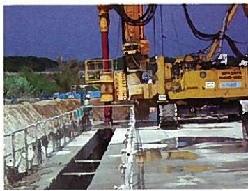
▲止水壁を築造
