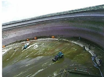
▲ファームポンド底盤清掃
