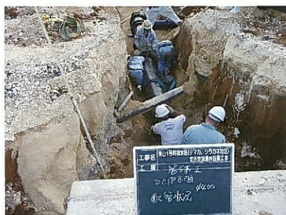
ダクタイル管布設状況
