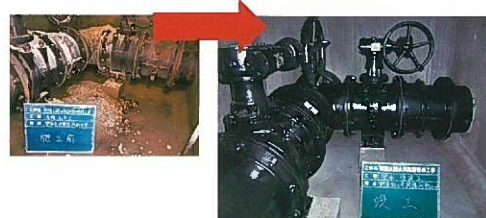
▲制水弁防水工事
