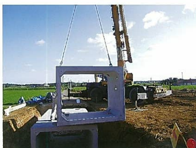
弁室設置状況
