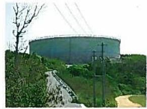
ファームポンドとは、取水施設から汲み上げた地下水を一時的に貯留する施設です。また、畠地へ地下水を送り出す働きをします。自然丘により地下水を送り出すため、標高の高い所に建設されています。
